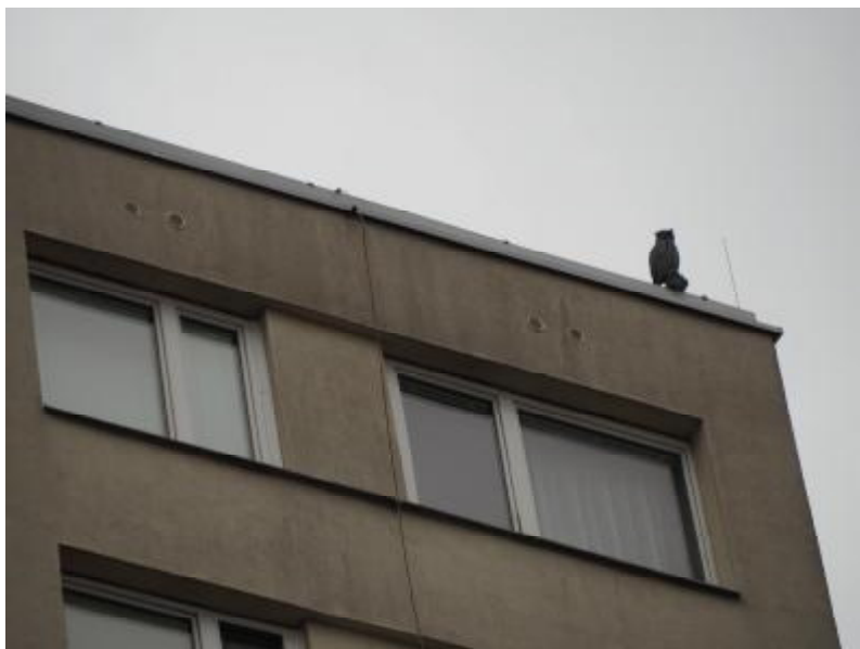
FOTO 4 : Tmavší povrch atik v průčelí v důsledku nárůstu mikroorganismů
